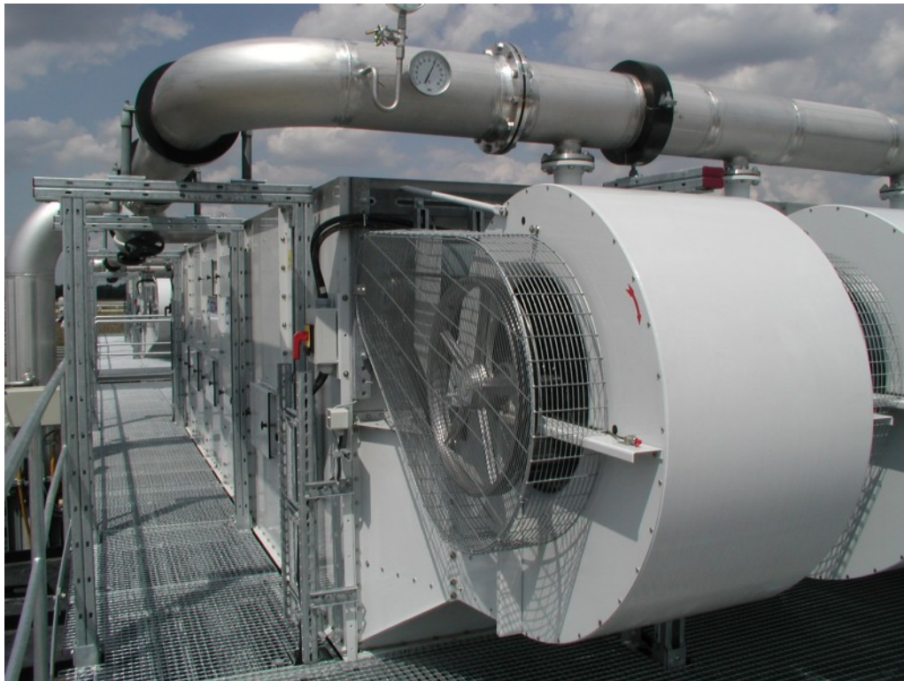
Flughafen Frankfurt am Main - 12 Megawatt-Kühlturmanlage mit Wasserspeicher
