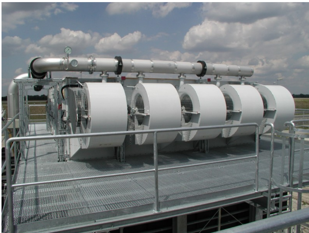
Flughafen Frankfurt am Main - 12 Megawatt-Kühlturmanlage mit Wasserspeicher
